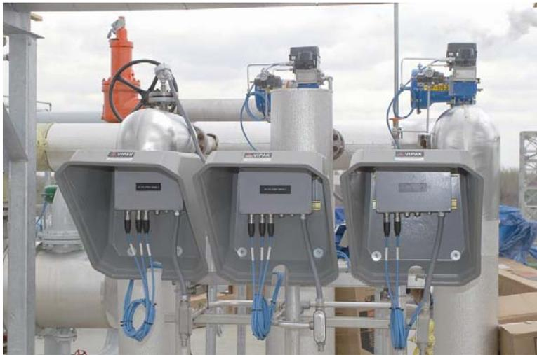
Bild 3: Feldbusbarrieren mit FISCO-zertifizierten, eigensicheren Feldgeräteanschlüssen
